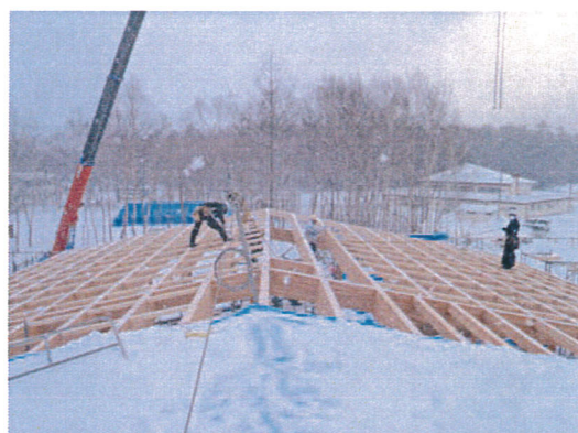
写真2 厳冬の雪が降るなかでの建設作業
